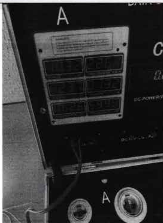
Foto 14 – Amostra do item 1.2.4 – medições de parâmetros elétricos
