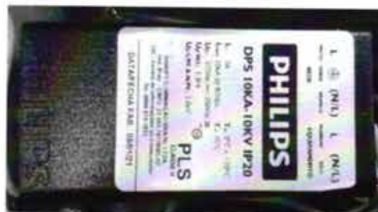
Foto 10 - Dispositivo Protetor de Surto
