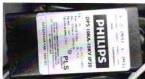
Foto 10 - Dispositivo Protetor de Surto
