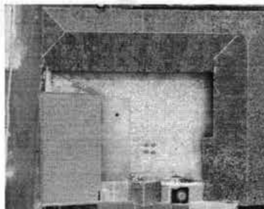
Figura 11 – Telhado cerâmico da CEMEI Dona Benta
