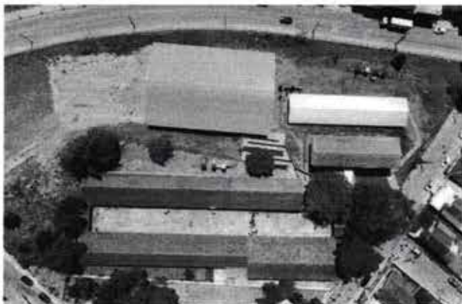
Figura 9 – Telhado cerâmico da Escola Municipal José Ribeiro de Carvalho
