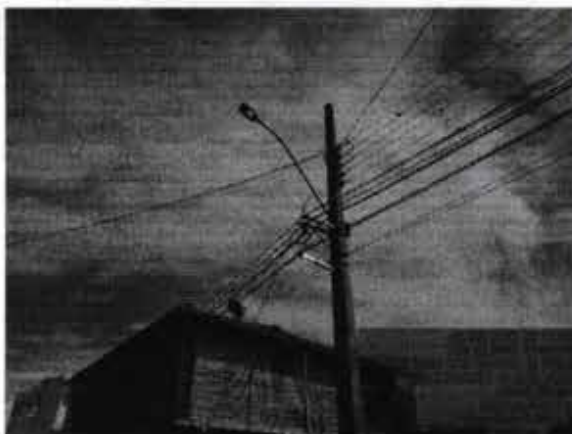
Figura 1 - Poste de concreto DT com lâmpada Vapor de Mercúrio, localizado na Rua Dona Ana Cândido de Paiva.
