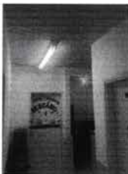
LUM 2 - Luminária de sobrepor retangular x2 lâmpadas (120 cm) Local: E.M. Chapeuzinho Vermelho.
