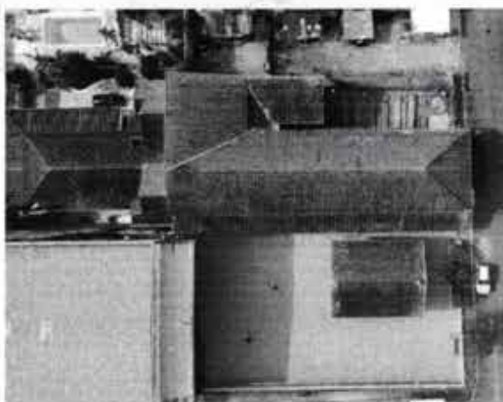
Figura 11 – Telhado cerâmico da Escola Municipal Prof. Maria da Costa Ferreira
