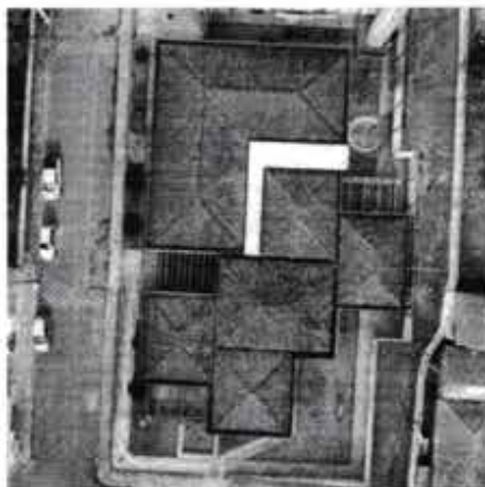
Figura 9 – Telhado cerâmico da CEMEI Olívia Cortes
