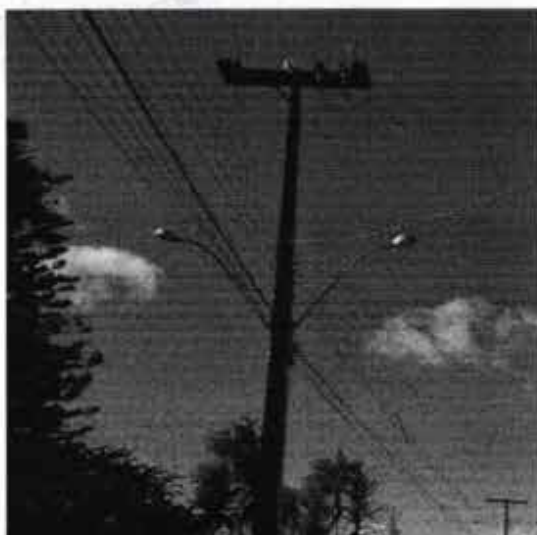
Figura 4 – Postes com braços de iluminação pública, respectivamente Tipo Leve I e Tipo PA4
