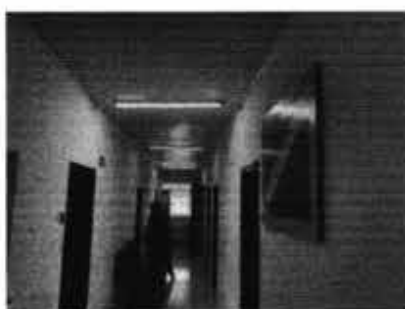
LUM 2 - Luminária de sobrepor retangular para 2 lâmpadas fluorescentes de 40 W (120 cm) Local: Prefeitura Municipal de Turvolândia,
