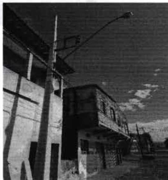
Figura 2 – Poste de do tipo concreto circular com luminárias aberta com lâmpada vapor de sódio de 100 W, localizado na via Vereador Ciro Ferreira de Alvarenga.
