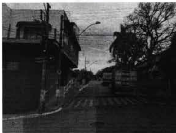
Figura 1 - Poste de concreto DT com luminária LED, localizado na Rua Engenheiro João Monteiro de Castro esquina com Rua Nossa Senhora das Graças
