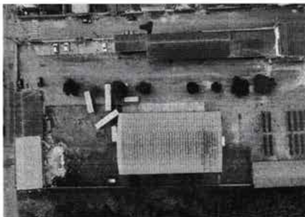
Figura 8 – Telhado cerâmico da E.M. Paulo Afonso V
