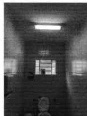
LUM 5 – Luminária de sobrepor retangular x2 lâmpadas (60 cm) Local: Unidade da Saúde da Família Ponte Segura
