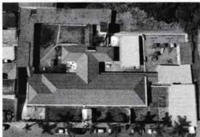
Figura 13 – Telhado cerâmico da Creche Santa Rita
