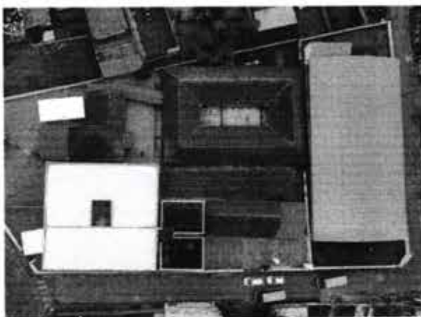
Figura 8 – Telhado cerâmico da E.M. Padre Chiquito.
