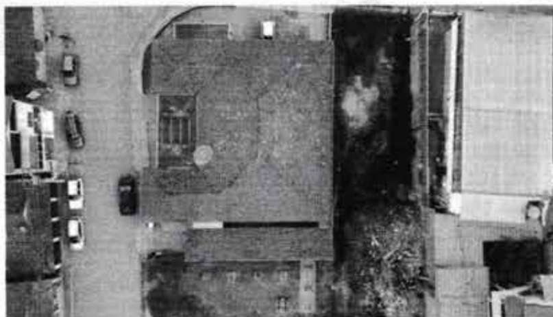
Figura 11 – Telhado cerâmico da Ubs Ponte Segura
