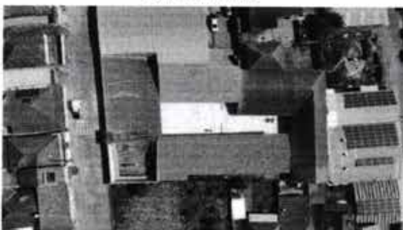
Figura 10 – Telhado cerâmico da Escola Municipal Benedito C Faria
