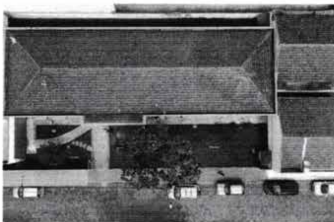
Figura 17 – Telhado cerâmico da PFS 5
