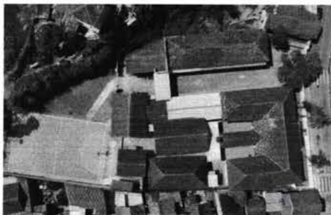
Figura 11 – Telhado cerâmico da Escola Municipal Cel. Joaquim Inácio
