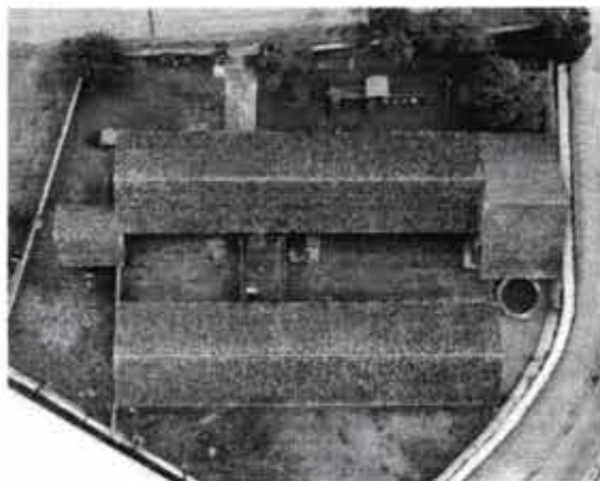
Figura 10 – Telhado cerâmico da Escola Municipal Monsenhor Dr. Furtado
