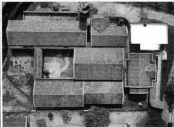
Figura 13 – Telhado cerâmico e metálico da Escola Municipal Pingo de Gente
