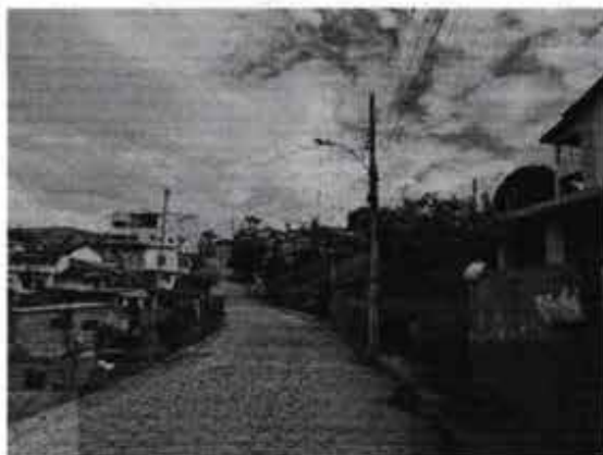
Figura 1 - Poste de concreto DT com lâmpada Vapor de Sódio, localizado na Rua Prefeito Afonso Troysi
