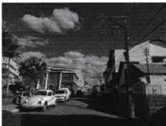
Figura 1 - Poste de concreto DT com luminária LED, localizado na Avenida Antônio Paulino
