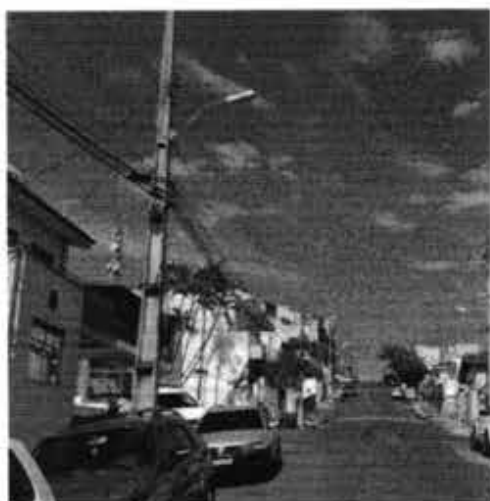
Figura 4 – Braços tipo Leve II fora de padrão.
