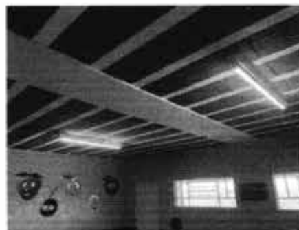
LUM 8 - Luminária de sobrepor retangular x1 lâmpada (120 cm) Local: Creche C. Augusto Jose de C.
