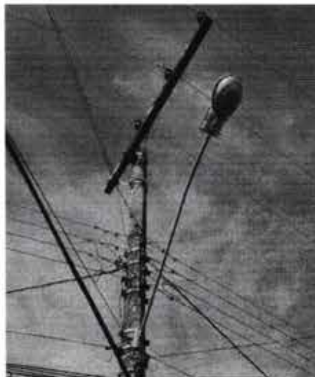
Figura 5 – Luminárias com refrator danificado (amarelado)
