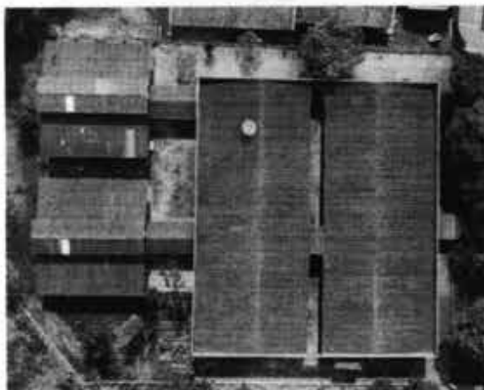
Figura 12 – Telhado metálico da Escola Municipal Padre Reginaldo
