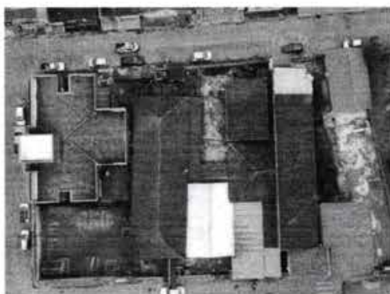
Figura 9 – Telhado cerâmico da Escola Municipal Prof. Carlito
