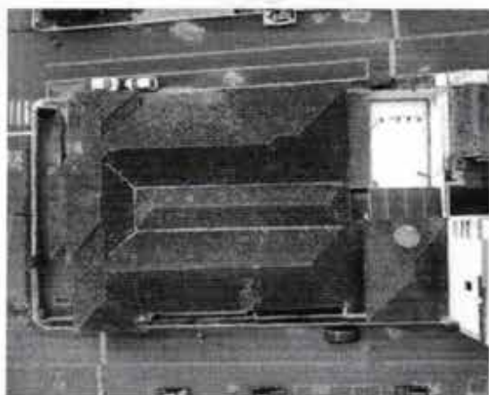
Figura 9 – Telhado cerâmico da Creche Municipal Tereza Rodrigues de Souza
