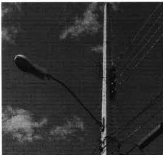
Figura 5 – Luminárias com refrator danificado (amarelado)
