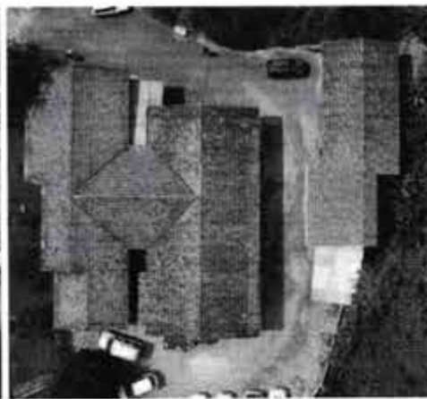
Figura 15 – Telhado cerâmico do Pronto Socorro Raimundo H. Silva
