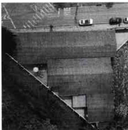
Figura 10 – Telhado metálico da Escola Municipal Elvira De Castro Bernardes
