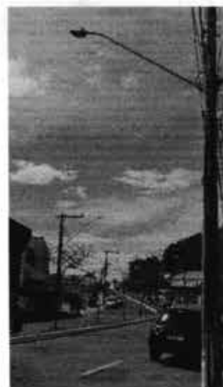
Figura 2 – Poste de concreto DT com luminária LED, localizado na Avenida das Fontes.
