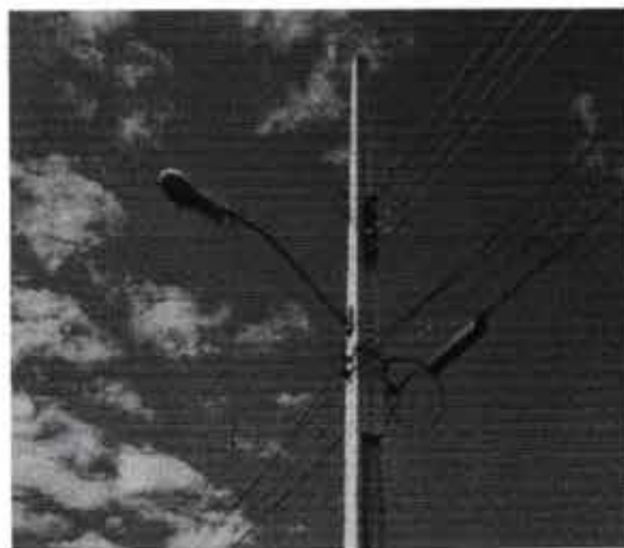
Figura 4 – Braços tipo Leve II fora de padrão.
