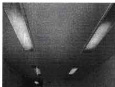
LUM 1 – Luminária de embutir retangular para 2 lâmpadas fluorescentes de 40 W (120 cm)
