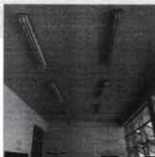
LUM 2 - Luminária de sobrepor retangular para 2 lâmpadas fluorescentes de 40 W (120 cm)
