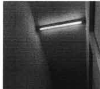
LUM 9 - Luminária de sobrepor retangular para uma 1 lâmpada fluorescentes de 40 W (120 cm)
