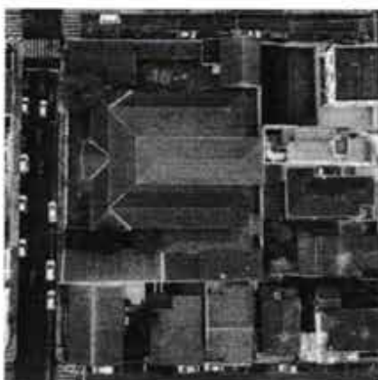
Figura 6 – Telhado cerâmico da Escola Municipal Bonifácio
