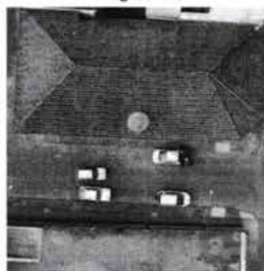
Figura 10 – Telhado cerâmico da UBS Monsenhor Pedro Cintra
