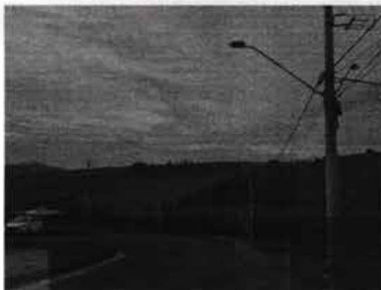
Figura 1 - Poste de concreto circular com luminárias fechadas com lâmpada vapor de sódio, localizado no cruzamento das vias Av. Brasil esquina com R. Cel. Evaristo Silva
