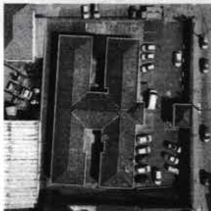
Figura 16 – Telhado cerâmico do Centro Municipal de Saúde
