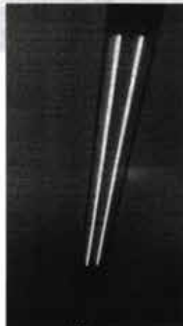
LUM 13 - Luminária de embutir retangular x2 lâmpadas (120 cm) Local: Ubs Camanducaia
