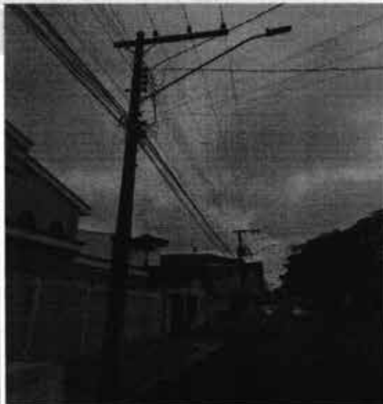
Figura 2 – Poste de concreto duplo T com luminária LED na Av. Antônio Carlos
