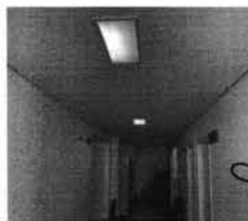
LUM 9 - Luminária de embutir retangular x2 lâmpadas (120 cm) Local: Ubs Nossa Senhora Aparecida
