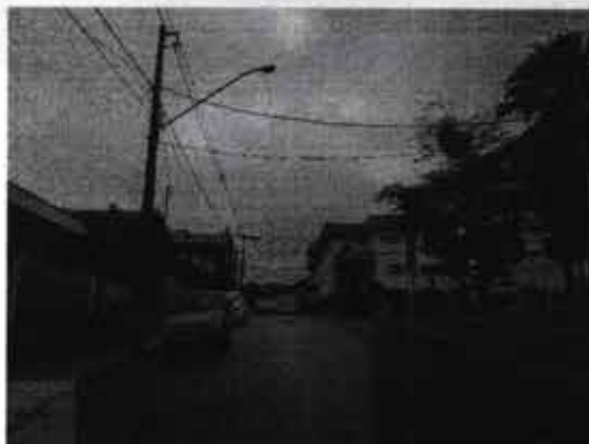
Figura 1 - Poste de concreto DT com luminárias LED 80 W, localizado na Rua João Botelho Muniz (Praça Nossa Senhora Aparecida)
