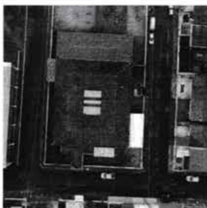
Figura 4 – Telhado cerâmico da Creche Pingo de luz
