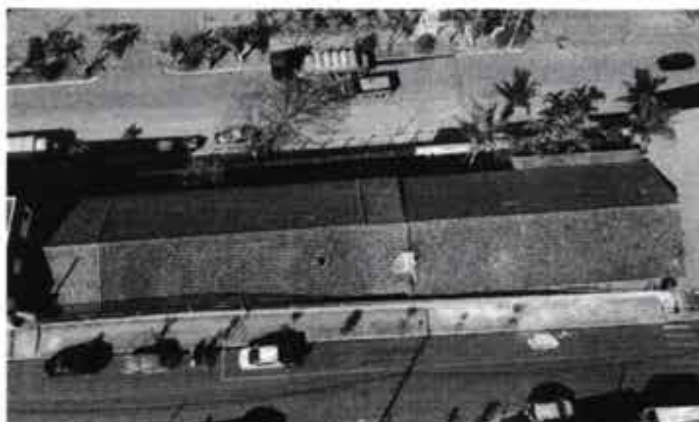
Figura 11 – Telhado cerâmico da Escola Municipal Iolanda Capobianco
