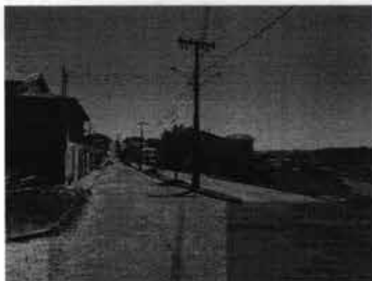
Figura 1 - Poste de concreto circular com 2 braços, luminárias abertas e lâmpadas vapor de sódio, localizado na Av. Lourival de Campos Reis.
