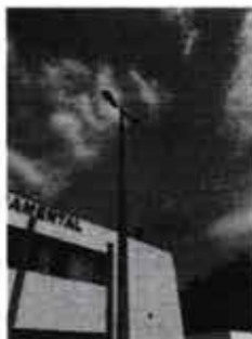
LUM 10 - Luminária de iluminação pública convencional Local: E.M. Onofre Vargas
