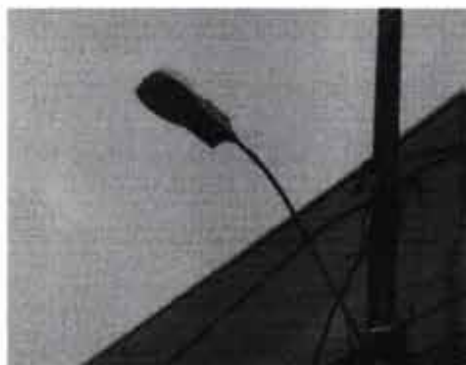
Figura 5 – Luminárias com refrator de policarbonato danificado ou faltando.
