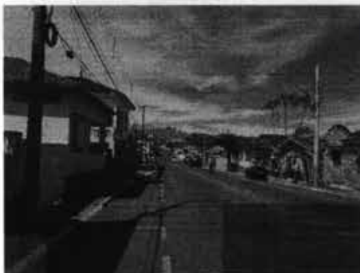
Figura 1 - Poste de concreto circular com lâmpada Vapor de Sódio, localizado na Av. Coronel Domingos Rosa
