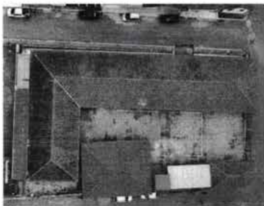
Figura 10 – Telhado cerâmico da Escola Municipal Prof. Maria José
