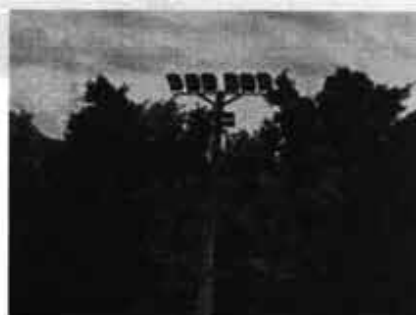
LUM 6 – Projetor retangular para lâmpadas de 400 W.
