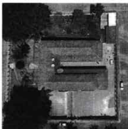
Figura 12 – Telhado cerâmico da Escola Municipal Dr. Moreira Brandão
