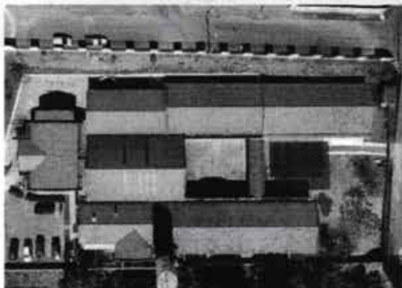
Figura 9 – Telhado cerâmico da CEMEI Prof. Maria José
