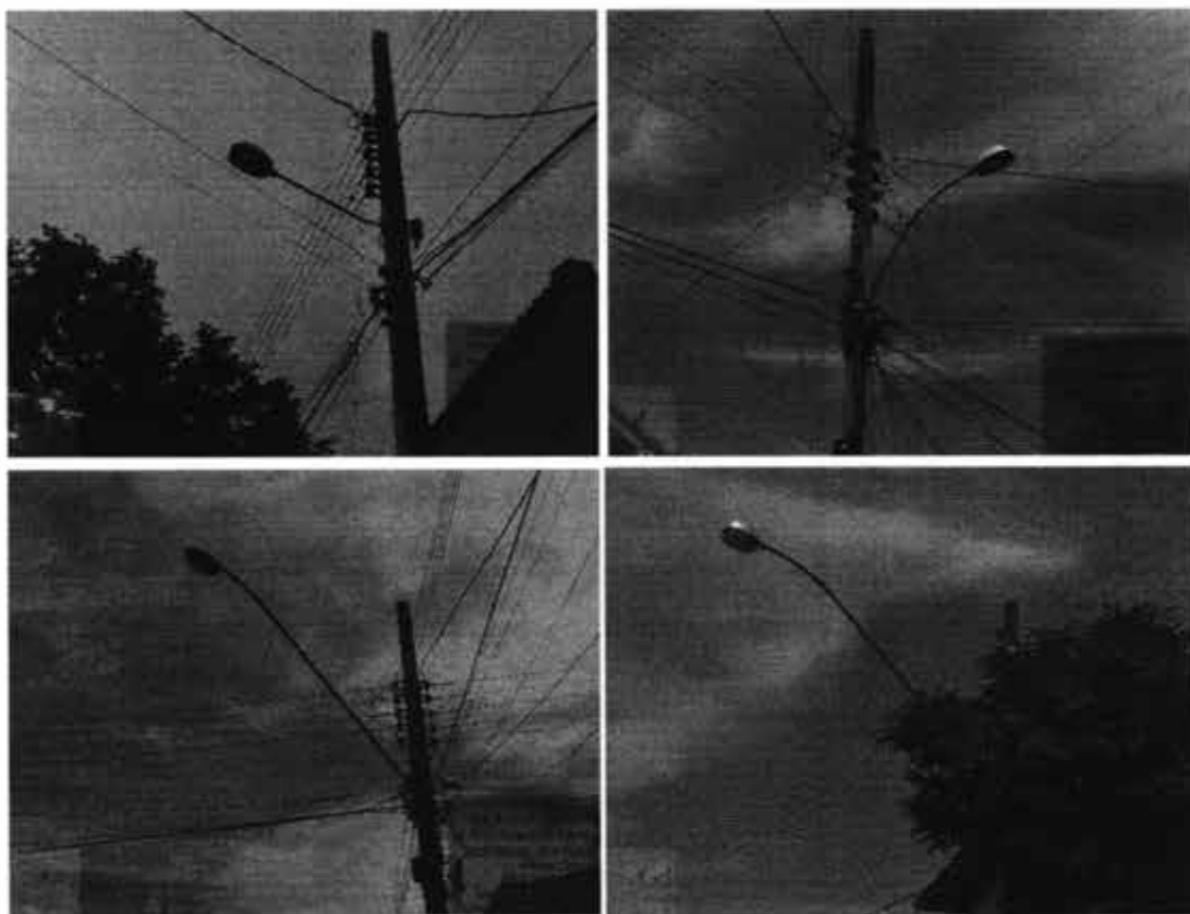
Figura 3 – Compilado de fotos exemplificando os tipos mais comuns de luminárias, braços e postes identificados no parque de iluminação.
