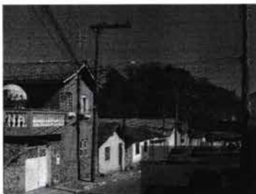
Figura 1 - Poste de concreto circular com luminária aberta lâmpada Vapor de Sódio, localizado na Coronel Elpidio Campos do Amaral.
