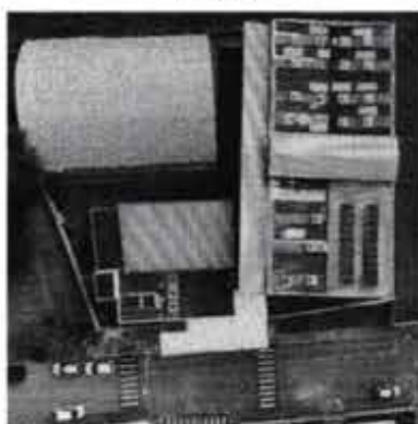
Figura 9 – Telhado metálico da Escola Municipal Prof. Diva Santos
