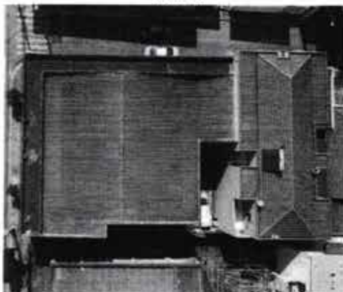
Figura 12 – Telhado de fibrocimento do prédio da Prefeitura
