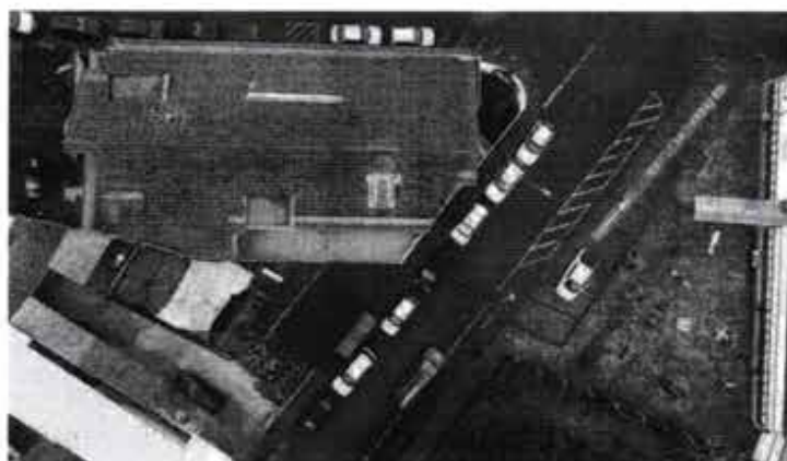
Figura 10 – Telhado cerâmico do Posto de Saúde Irmã Maria
